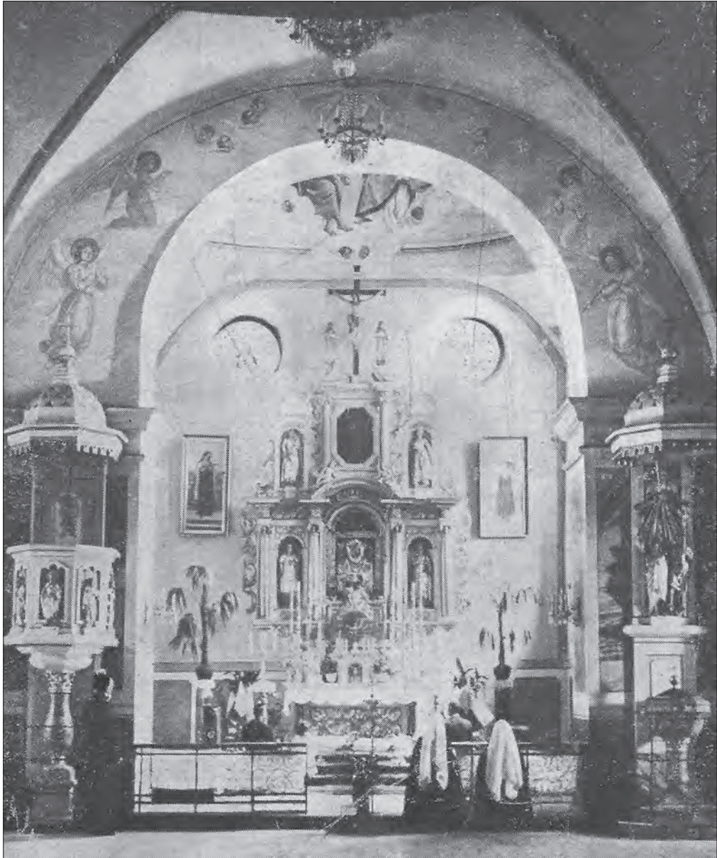
Fot. 17 Wnętrze kościoła pw. Św. Aleksego w Przedborzu, 1931 r.
