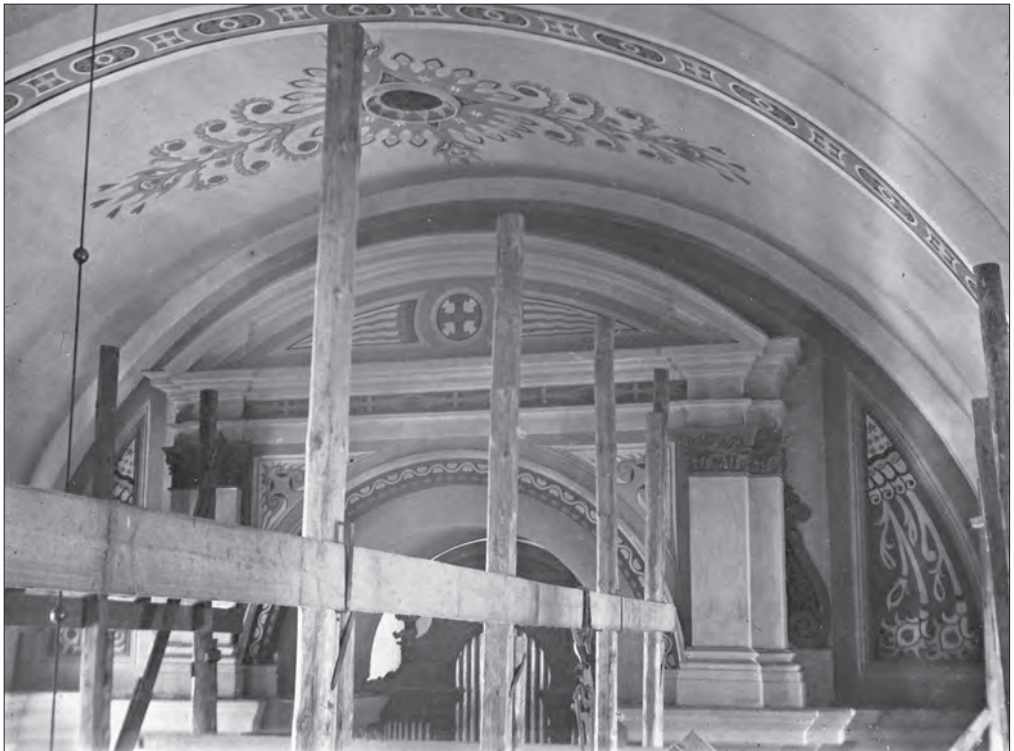
Widok na sklepienie nawy głównej i organy
