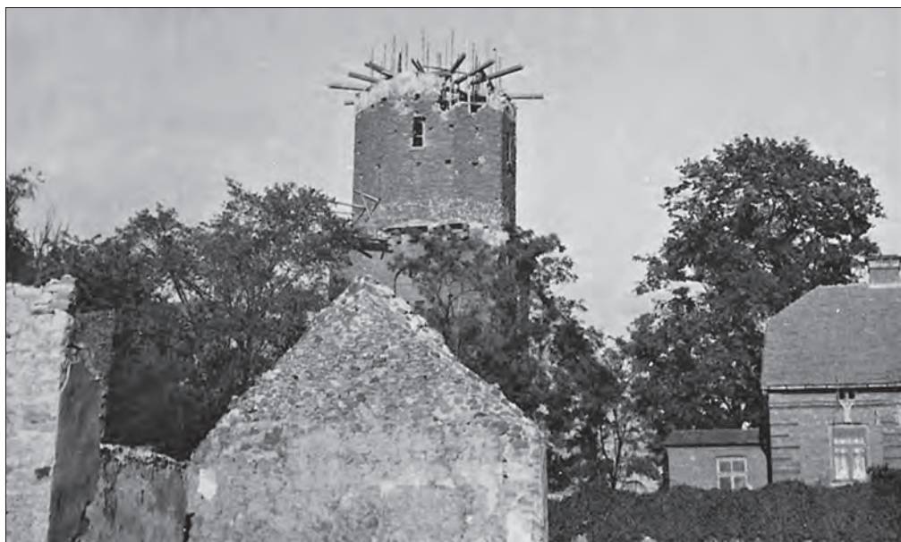
Fot. 19 Odbudowa wieży kościoła pw. Św. Aleksego w Przedbórz w trakcie remontu, po 1945 r.
