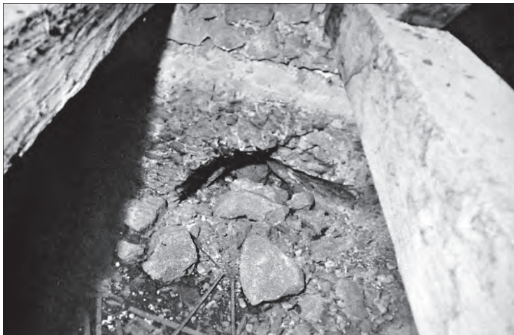
Fot. 2 Okno w poddaszu ponad sklepieniem kolebkowym nawy głównej, ściana południowa, od strony wschodniej
