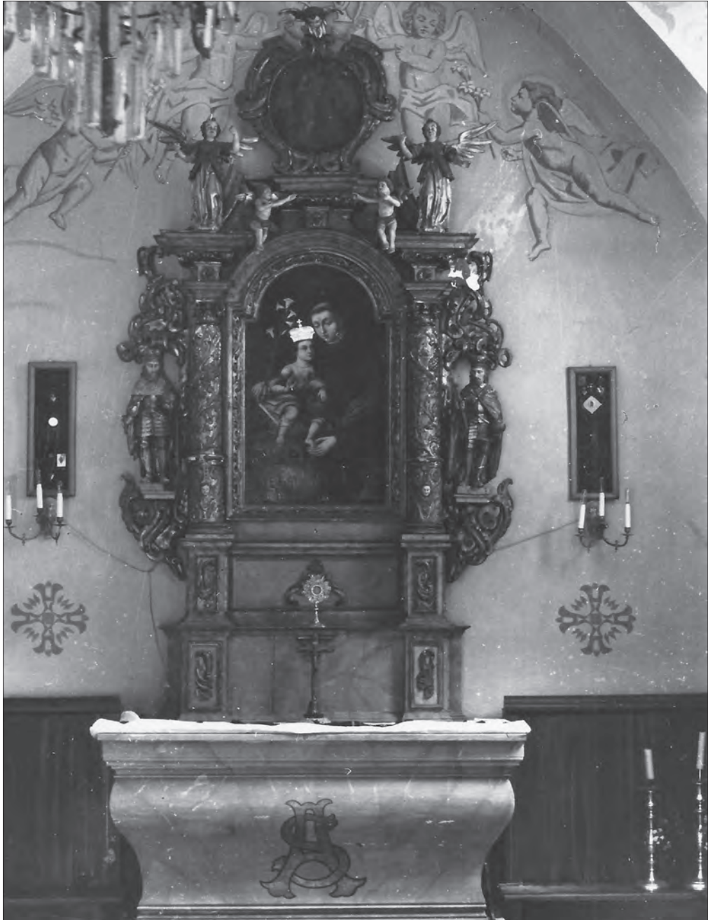
Fot. 21 Kaplica boczna pw. Św. Antoniego Padewskiego, 1950 r.
