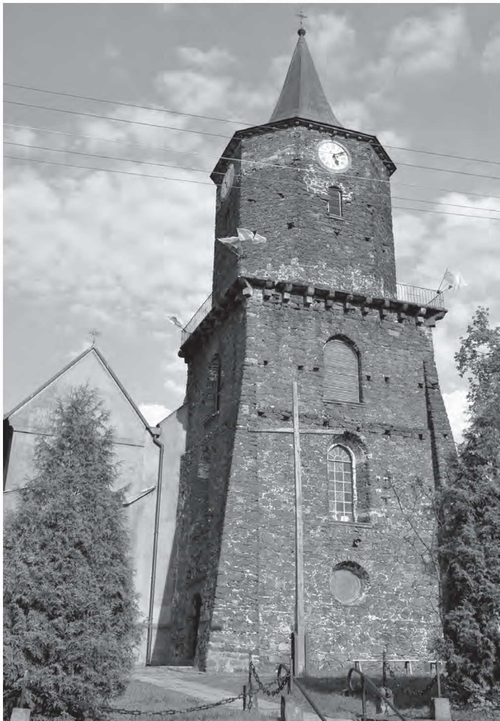
Fot. 4 Wieża kościelna, 1341r., fundator Król Kazimierz Wielki
