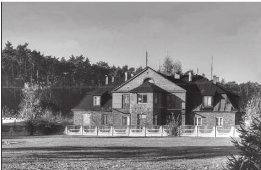
Willa Alfonsa Kosińskiego w Gomunicach („Stara Szkoła”), ul. Piłsudskiego. Stan z 2015 r.
