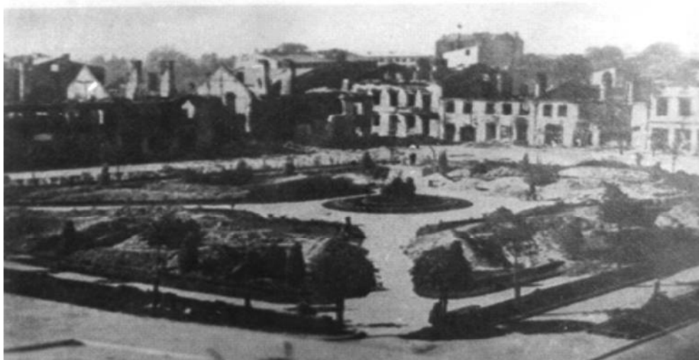
Zniszczenia wojenne w rynku
