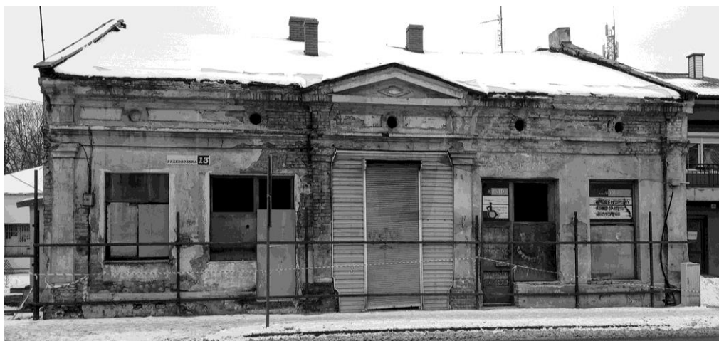
Budynek dawnej mykwy, 2 lutego 2021 r., fot. T. Nowak
